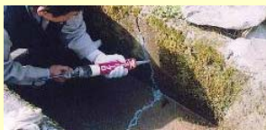
水路のひび割れ補修
