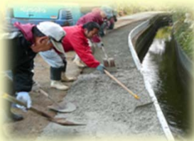
【水路の簡易補修】
