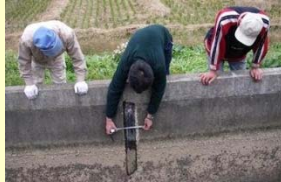
施設の機能診断
