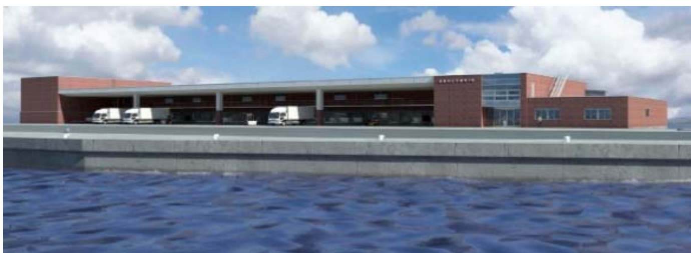
高度衛生管理型漁港の整備
