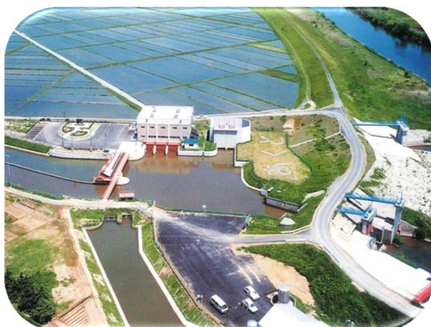
排水施設の整備
