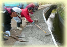
【水路の簡易補修】
