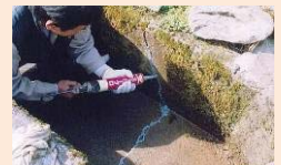
水路のひび割れ補修
