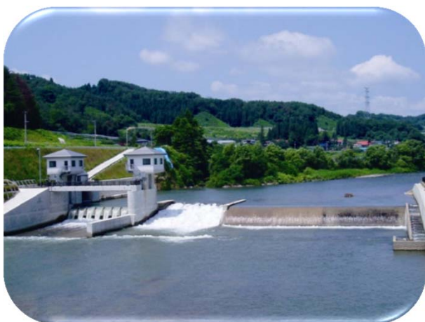
農業水利施設の補修・更新
