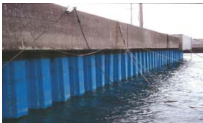
漁港施設の補修・更新
