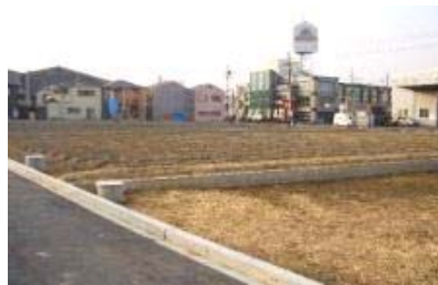
農業用排水施設
