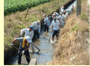
水路の泥上げ
