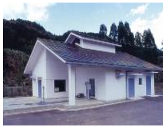
簡易給排水施設
