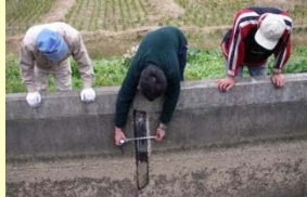
施設の機能診断
