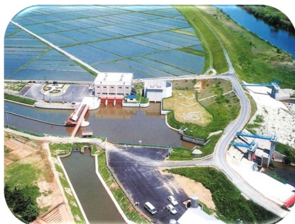
排水施設の整備
