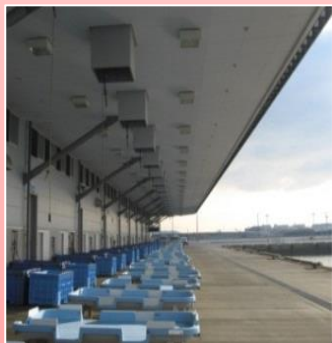
鳥獣対策を施した陸揚岸壁
