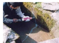
水路のひび割れ補修
