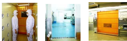
エアシャワー 床面 ゾーンシャッター
