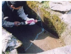
水路のひび割れ補修
