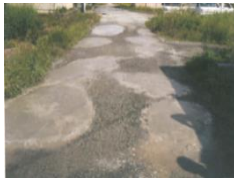
農道の窪みの補修
