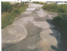
農道の窪みの補修
