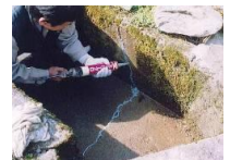
水路のひび割れ補修
