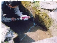
水路のひび割れ補修
