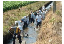
水路の泥上げ
