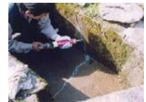
水路のひび割れ補修
