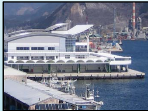
高度衛生管理に対応した岸壁・荷さばき所の一体的整備
