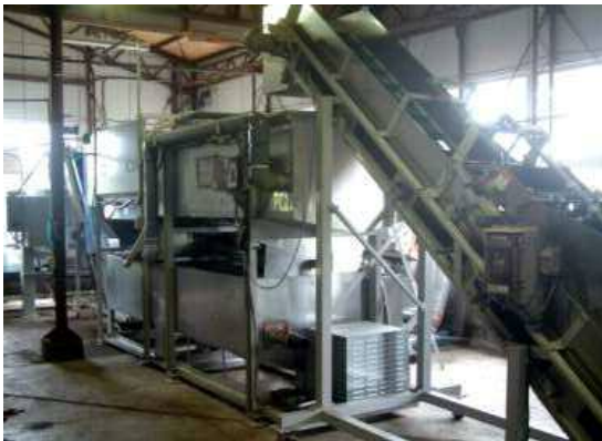
被害を防除・最小化させるために必要な洗浄用機械施設整備等を実施
