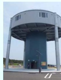
津波避難タワー
