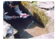
水路のひび割れ補修
