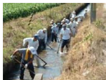
水路の泥上げ
