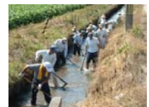
水路の泥上げ
