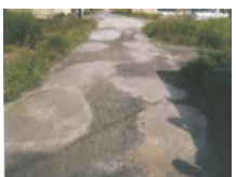
農道の窪みの補修
