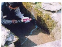
水路のひび割れ補修
