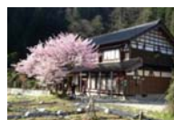
古民家等の改修
