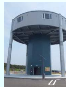
津波避難タワー
