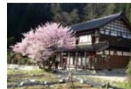
古民家等の改修
