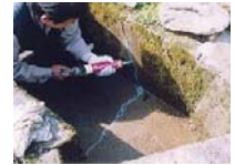
水路のひび割れ補修
