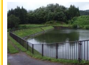
転落防止柵の整備
