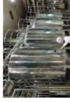
生クリーム貯蔵施設
