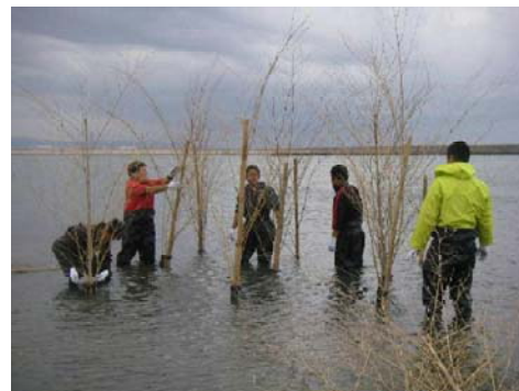
《《逆さ竹林タイプの保護礁設置》》
