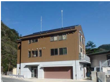
木造新築庁舎
