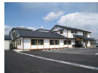
写真上：岡山県津山市 岡山森林管理署 新庁舎外観 下：同庁舎玄関フロア
