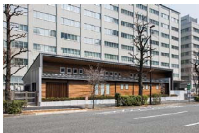
木造新築庁舎
