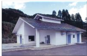
簡易給排水施設
