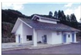
簡易給排水施設
