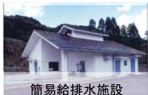
簡易給排水施設
