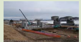
かんがい施設の整備
