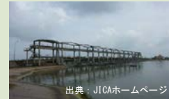
出典: JICAホームページ 防潮堰
