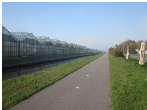
〔施設園芸の温室〕
