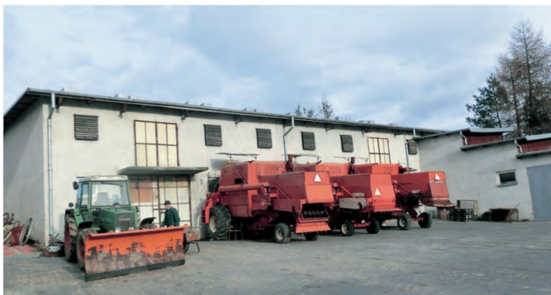
写真資料1 CAP補助金を用いて整備した畜舎
