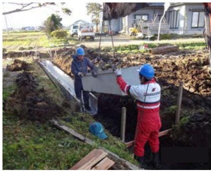
用水路更新（山形県）
