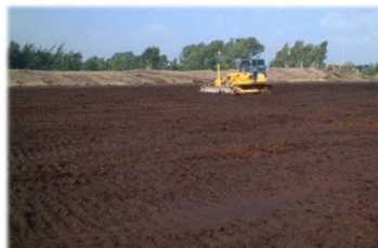
大規模な整地工
