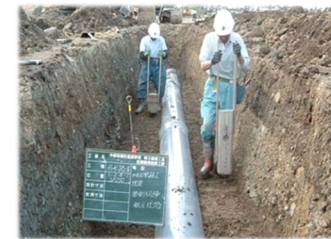
水路の管路化
