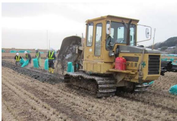
写真-19.1 トレントチャ工法の施工状況
