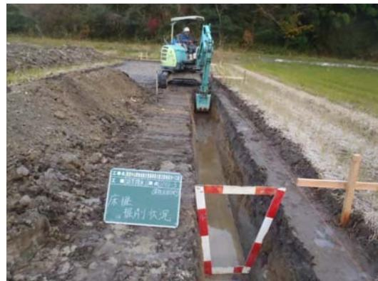
写真-19.2 バックホウ工法の施工状況
