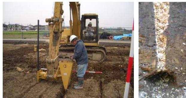
写真-26. 1 アーム式補助孔形成装置による施工と断面
