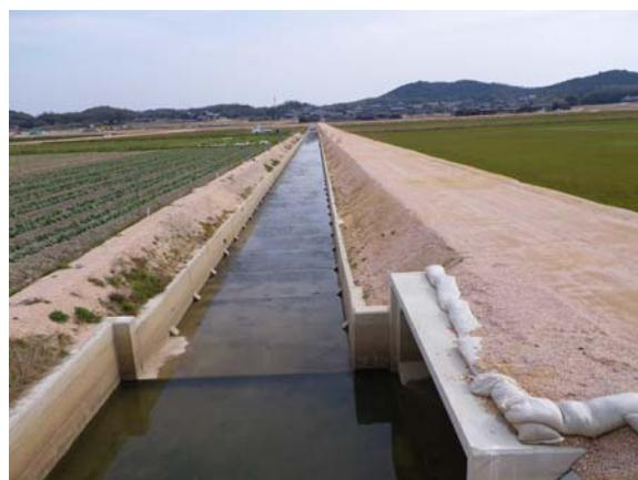
写真-28.1 排水路（底部）のライニング施工事例
