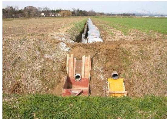
写真-6.8 流末側の三角堰設置例
