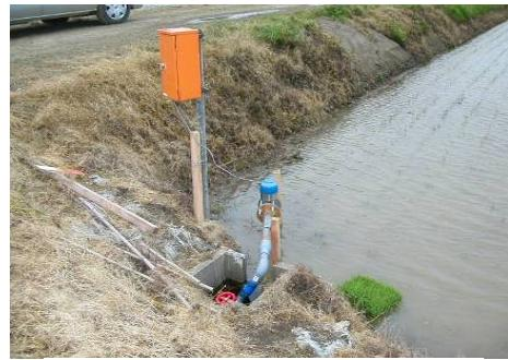
写真-6.4 電磁式積算流量計設置
