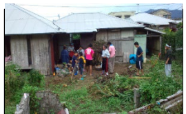
空き家や改修作業の様子
