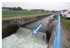
発電地点 (設置前)
