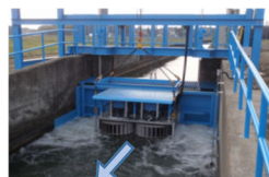
発電施設 (設置後)
