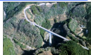
完成した夕日の里大橋
