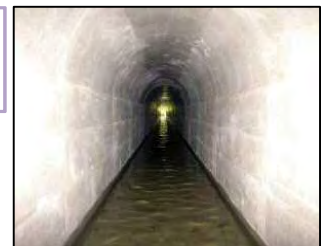
改修された水路トンネル
