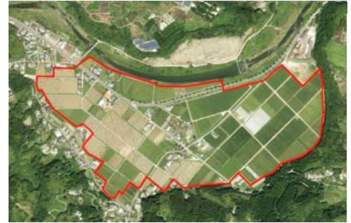
基盤整備の状況 ※H24撮影
