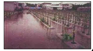
湛水被害状況(農地)
