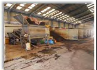
堆肥化施設(下川原)
