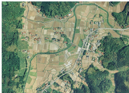
基盤整備前の岩永本郷地区
