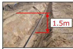
深暗渠の施工状況
