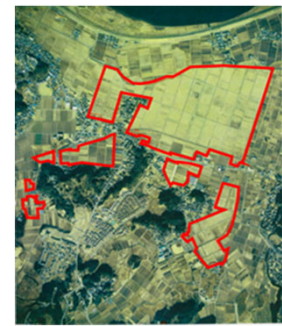
施工後全景(H11)
