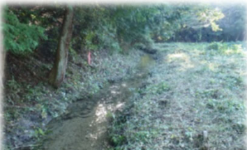
用排水兼用の土羽水路
