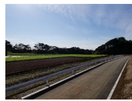
荷痛み等を抑制した整備された農道
