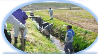
管理が大変な土水路
