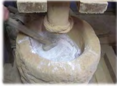
当事の「通潤橋仕法書」に基づき漆喰を再現
