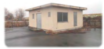
旧処理場を水防施設として活用
