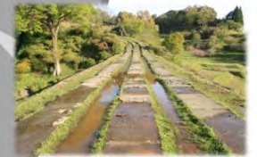
被災による橋上部への漏水
