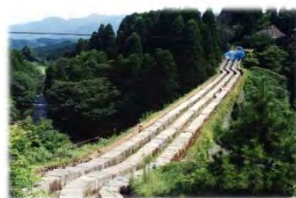
改修された石管 (水管橋上部)
