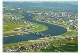
福岡、佐賀の両県に用水供給を行う筑後大堰
