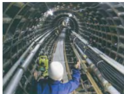
九頭竜川河底を横断するサイホン施工のためのシールド工事
