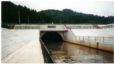
新々樋曾山隧道
