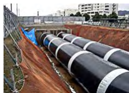
直径約3mの鋼管(2連)の敷設状況
