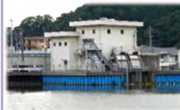
・排水機場の増設 (池ノ内)
