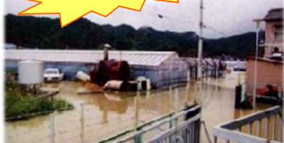
湛水被害の状況 (H5)
