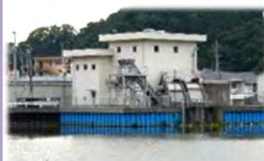
・排水機場の増設 (池ノ内)
