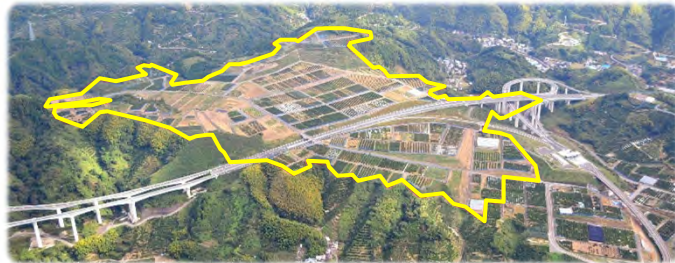
建設発生土を受け入れ、約84億円のコストを縮減するとともに、道路用地を創出した「新丹谷地区」
