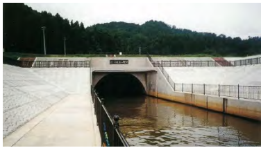
新々樋曾山隧道
