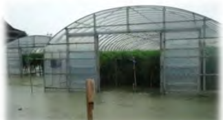
湛水被害を受けるハウス施設
