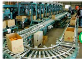
にんじん洗浄選別施設
