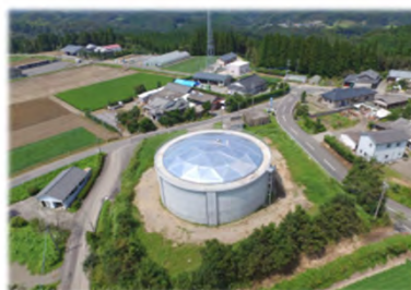
新たに整備されたファームポンド
