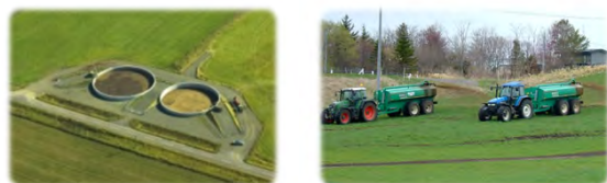
肥培かんがい施設と堆肥の散布状況
