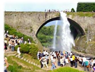
豪快な水しぶきをあげる 観光放水
