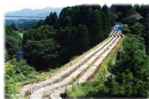
改修された石管 (水管橋上部)
