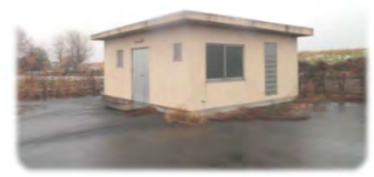
旧処理場を水防施設として活用
