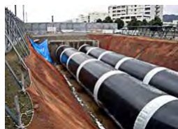
直径約3mの鋼管(2連)の敷設状況
