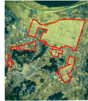
施工後全景(H11)
