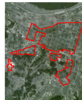
施工前全景(H4)
