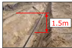
深暗渠の施工状況
