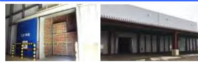
空気調整(CA)貯蔵庫 エチレン貯蔵施設
