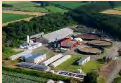
鹿追町環境保全センター (バイオガスプラント)
