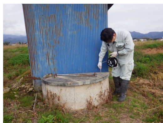
②ブザーが鳴ったら、その位置が地下水位です。
