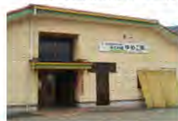
保育園を改修した工房
