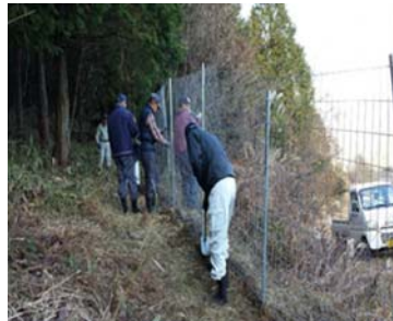
【獣害防止柵の設置】
