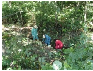
【排水路清掃作業】
