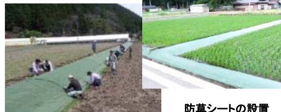
防草シートの設置
