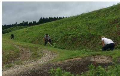
【法面の草刈作業】
