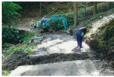
【道路整備作業の様子】
