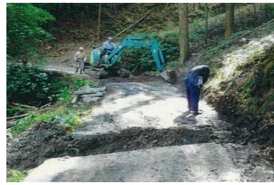
【道路整備作業の様子】
