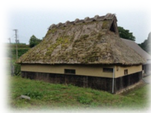
【笹葺き屋根の家】
